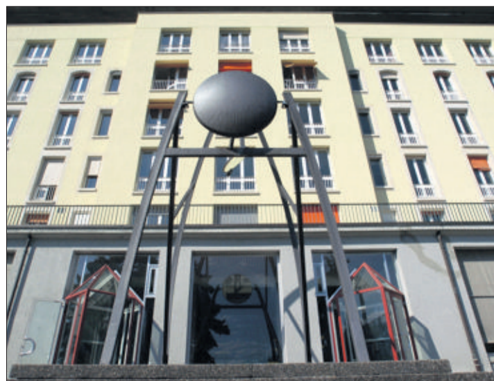
Le bâtiment de la HEP, à l'avenue de Cour, déborde. La Haute Ecole a mobilisé la totalité de ses ressources en termes d'enseignants et de locaux. La direction prévoit de chambouler les horaires des cours l'an prochain afin de maximiser l'occupation des salles de classe.
